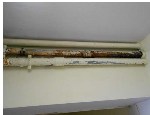
ΑΝΤΙΚΑΤΑΣΤΑΣΗ ΣΩΛΗΝΩΣΕΩΝ (ΠΥΡΟΣΒΕΣΗΣ, ΘΕΡΜΑΝΣΗΣ, ΖΕΣΤΟΥ-ΚΡΥΟΥ ΝΕΡΟΥ)
