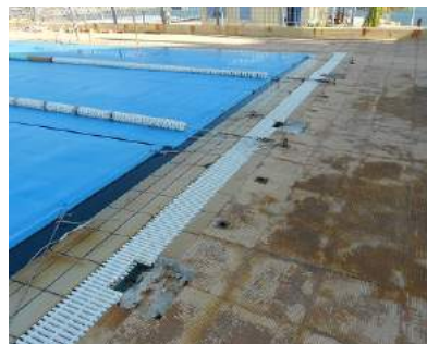
ΑΠΟΞΗΛΩΣΗ ΥΦΙΣΤΑΜΕΝΩΝ ΤΣΙΜΕΝΟΠΛΑΚΩΝ ΔΑΠΕΔΩΝ ΚΑΙ ΕΠΑΝΕΠΙΣΤΡΩΣΗ ΜΕ ΑΝΤΙΟΛΙΣΘΗΡΑ ΓΡΑΝΝΙΤΟΠΛΑΚΑΚΙΑ
