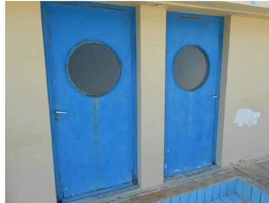
ΑΝΤΙΚΑΤΑΣΤΑΣΗ ΕΞΩΤΕΡΙΚΩΝ ΣΙΔΗΡΩΝ ΘΥΡΩΝ ΓΡΑΦΕΙΩΝ - ΕΜΠΡΟΣΘΕΝ ΤΗΣ ΚΥΡΙΑΣ ΚΟΛΥΜΒΗΤΙΚΗΣ ΔΕΞΑΜΕΝΗΣ - ΑΠΟ ΝΕΕΣ ΕΞΩΤΕΡΙΚΕΣ ΘΥΡΕΣ PVC
