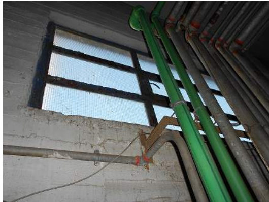
ΑΠΟΞΗΛΩΣΗ ΥΦΙΣΤΑΜΕΝΩΝ ΠΑΡΑΘΥΡΩΝ ΜΗΧΑΝΟΣΤΑΣΙΟΥ ΚΑΙ ΑΝΤΙΚΑΤΑΣΤΑΣΗ ΜΕ ΝΕΑ ΚΟΥΦΩΜΑΤΑ ΤΥΠΟΥ PVC
