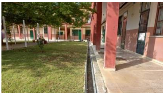
ΕΡΓΑΣΙΕΣ ΕΠΙΣΚΕΥΗΣ ΦΡΕΑΤΙΩΝ ΣΤΟ ΠΡΟΑΥΛΙΟ ΤΟΥ ΚΟΡΓΙΑΛΕΝΕΙΟΥ 1 ΟΥ ΓΥΜΝΑΣΙΟΥ ΑΡΓΟΣΤΟΛΙΟΥ
