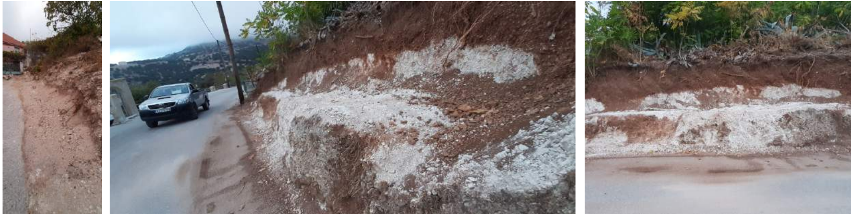
ΔΙΛΙΝΑΤΑ – ΚΑΤΑΣΚΕΥΗ ΛΙΘΟΔΟΜΩΝ
