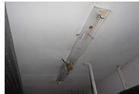
ΑΝΤΙΚΑΤΑΣΤΑΣΗ ΦΩΤΙΣΤΙΚΩΝ ΟΡΟΦΗΣ ΑΠΟΔΥΤΗΡΙΩΝ ΚΑΙ ΛΟΙΠΩΝ ΧΩΡΩΝ
