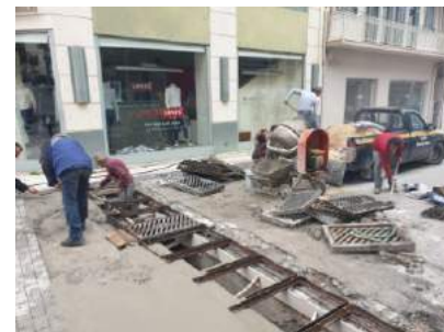
ΧΟΪΔΑ – ΣΧΑΡΕΣ ΒΕΛΤΙΩΣΗ & ΑΝΤΙΚΑΤΑΣΤΑΣΗ
