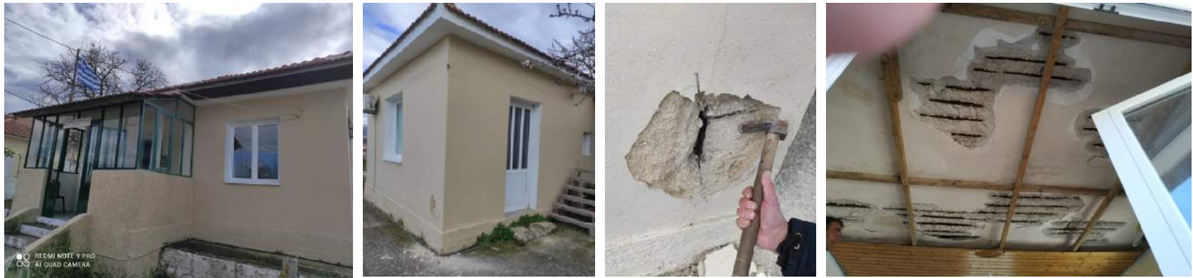
ΚΟΙΝΟΤΙΚΟ ΚΑΤΑΣΤΗΜΑ ΛΑΚΗΘΡΑΣ ΠΡΙΝ ΤΙΣ ΕΡΓΑΣΙΕΣ
